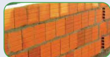
Argamassa de Assentamento
