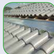
Vedação de telhados, calhas e rufos
