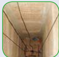
Poço de Elevadores
