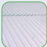
Telhas de Fibrocimento
