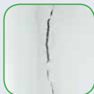
Reforço de ralos, trincas e fissuras
