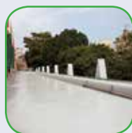
Lajes Expostas sem Circulação
