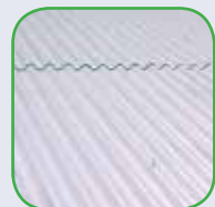
Telhas de Fibrocimento
