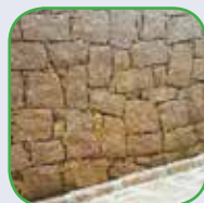
Muros de Arrimo
