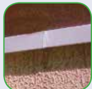
Fixação de Cantoneiras
