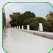
Lajes Expostas sem Circulação
