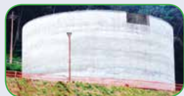
Reservatório de Água Potável
