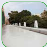
Lajes Expostas sem Circulação
