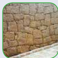
Muros de Arrimo
