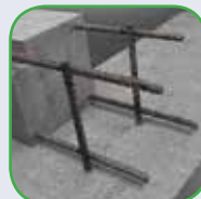
Arranques Vigas e Colunas
