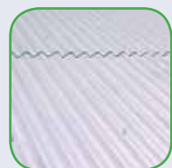
Telhas de Fibrocimento
