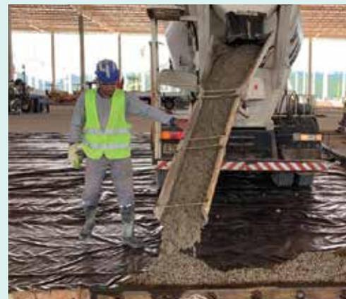
As fibras estruturais **TUF-STRAND SF**, compostas por um blend de polipropileno/polietileno, são patenteadas e podem ser utilizadas em uma variedade de aplicações para substituir com sucesso as fibras de aço e as telas soldadas. A **TUF-STRAND SF** foi desenvolvida para proporcionar maior ancoragem na matriz, garantindo reforço tridimensional ao concreto, ganho de resistência pós-fissuração, resistência ao impacto, à fadiga e controle das fissuras de retração.
