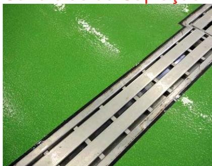
A instalação de canaletas de captação ou drenos irá evitar que o líquido derramado fique em contato direto com o revestimento.
